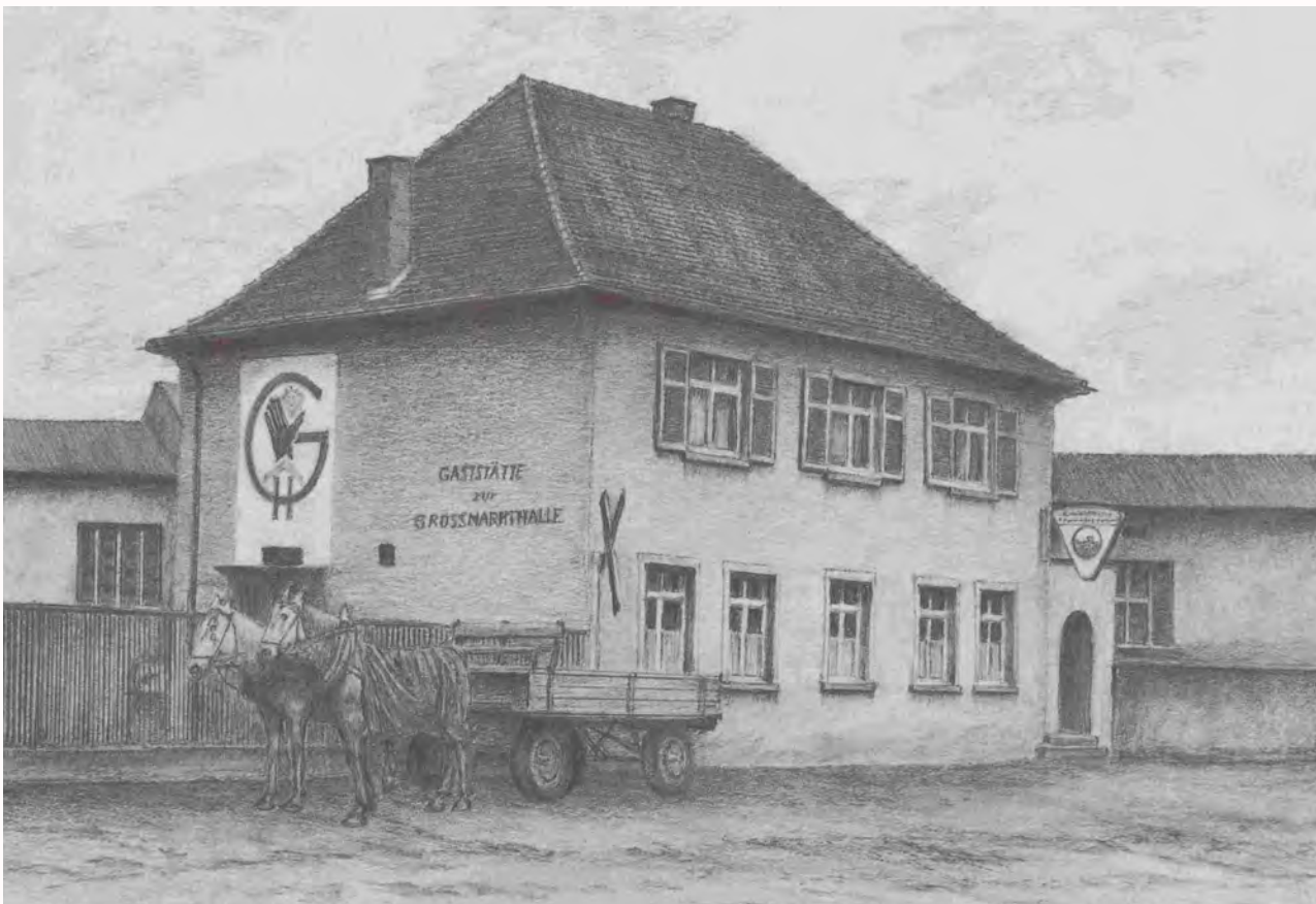
Alte Großmarkthalle mit Gaststätte Foto: Heidelberger Geschichtsverein
